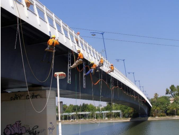
REPARACIÓN DE ESTRUCTURAS METÁLICAS
