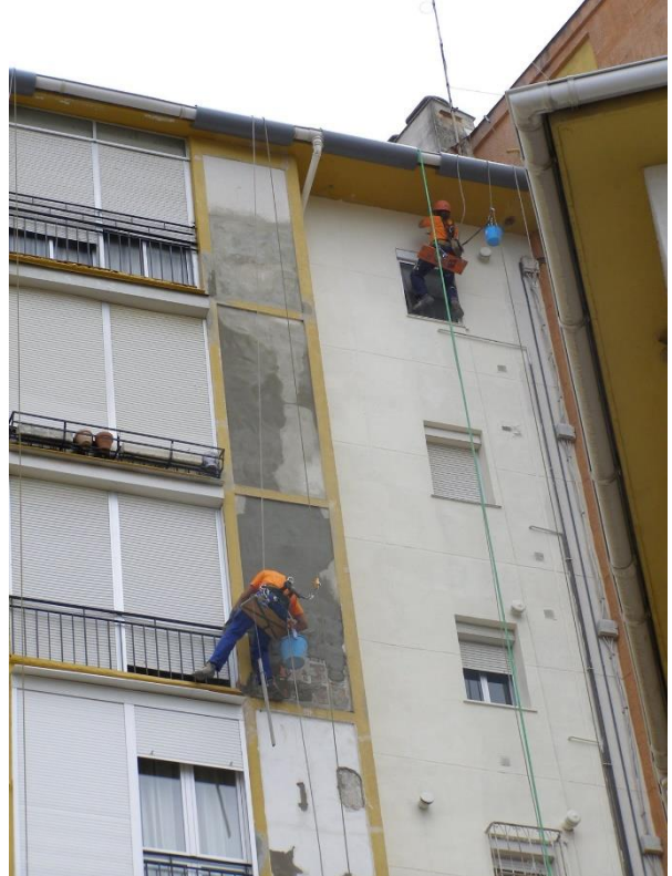
COLOCACIÓN DE VINILOS
