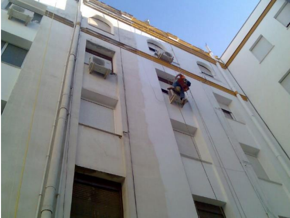
COLOCACIÓN DE CABLE FIBRA ÓPTICA
